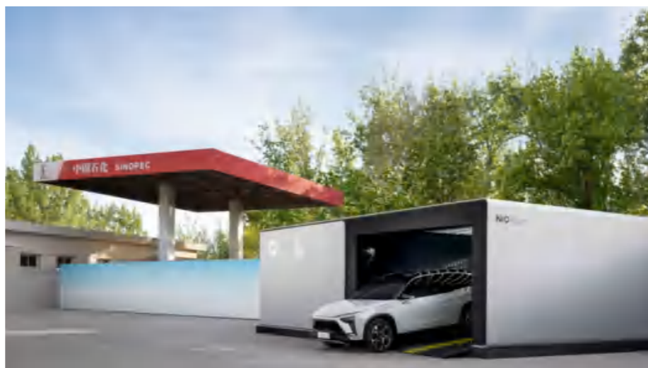
2021.04.15 蔚来全球首座第二代换电站正式启用
